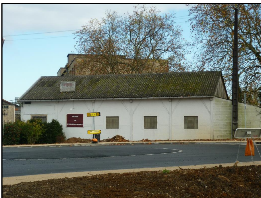
Façade Sud-Ouest sur voie et rond-point
