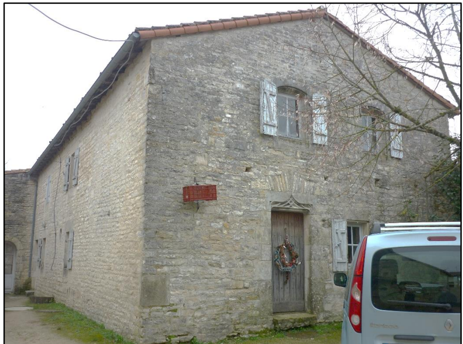
Pignon Sud-Ouest (Parcelle n° 468) Porte accès sur parcelle n° 424 (servitude)
