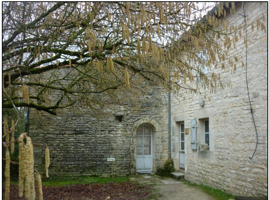
Façade Nord-Ouest Et porte d'accès du fonds voisin (parcelle n° 261)
