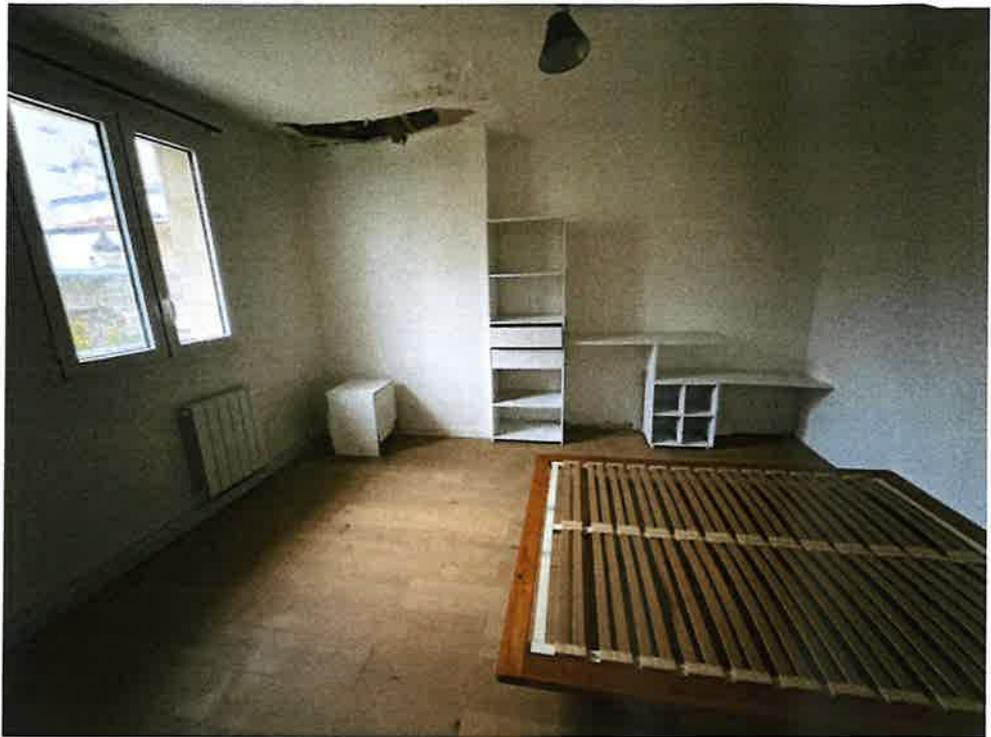
**État correct au rez de chaussée mais dégradé par les infiltrations de la toiture à l'étage.**
