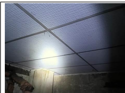
Photo n° PhA001 Localisation : Rez de chaussée - LOCAL CHAUDIÈRE Ouvrage : 4 - Plafonds et faux plafonds - Faux plafonds Partie d'ouvrage : Panneaux et plaques Description : plaques faux plafonds Localisation sur croquis : M001
