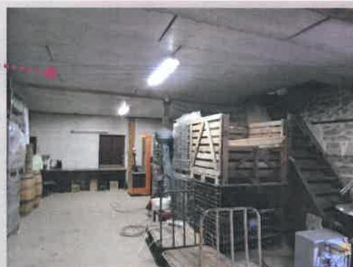
Pièce de stockage et habillage bouteilles construit dans les années 90, structurée par un sol béton; plafond bas isolé et doublé de plaques; poutres bois. Accès par échelle bois au Grenier R+1 (37 m<sup>2</sup>)
