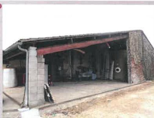
Appenti structure bois et IPN; murs en moellons; chape béton; 2 cuves INOX et 1 cuve fibro avec échelle d'accès.
