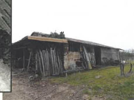
Structure comprenant 4 dépendances distinctes d'état général assez vétuste, avec différentes hauteurs de couverture. L'ensemble est constitué de tôle : 2 garages en ciment, chape béton—1 hangar structure métallique et taule avec une chape béton—1 garage et 1 dépendance en parpaings.
